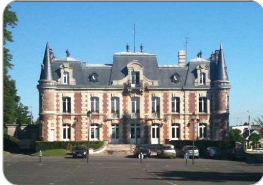
Le Château des Rochers Source : PLU 2013
